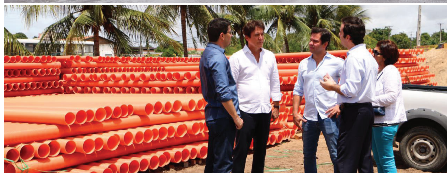
Governador Robinson Faria conferiu o andamento das obras coordenadas pelo Governo do Estado
